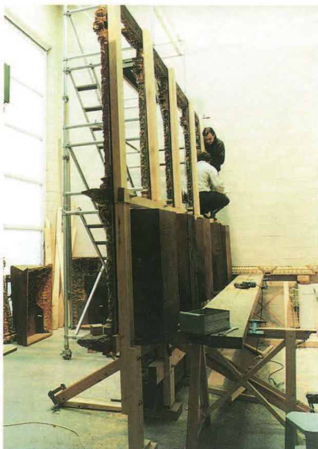
Estructura y montaje.
